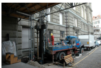
Sondierbohrungen, Erweiterungsbau Gegenwart
